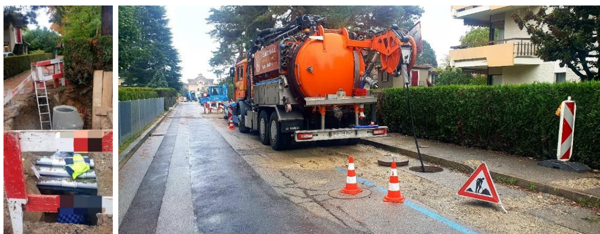
Entretien, reconstruction et réhabilitation des collecteurs publics
