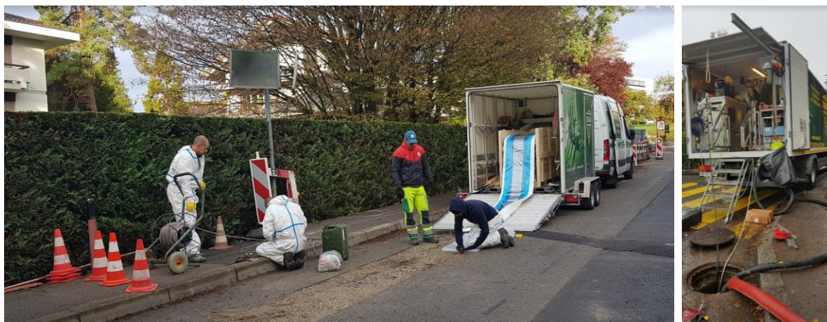
Installation de réhabilitation par gainage des collecteurs publics
