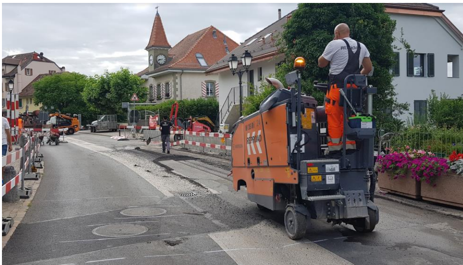
Reprise de fouille à la fin de l'intervention
