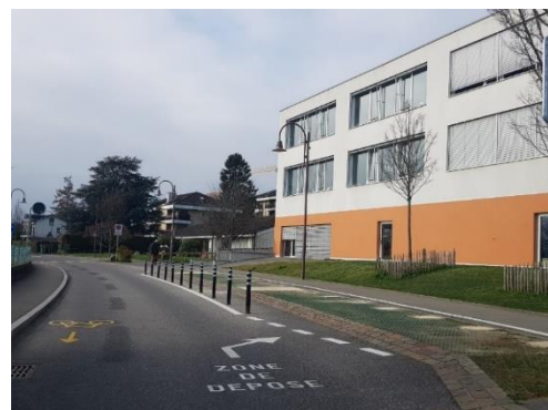
Zone de dépose au chemin des Pâquis
