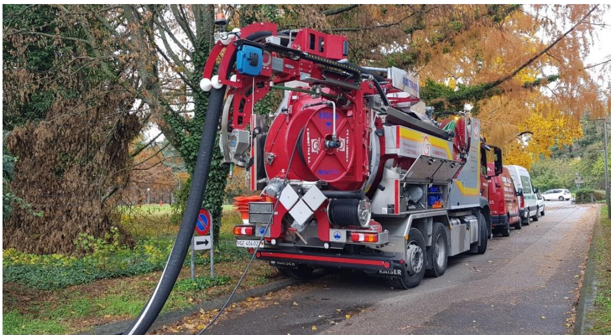
Installation d'un camion cureur pour l'entretien des collecteurs publics
