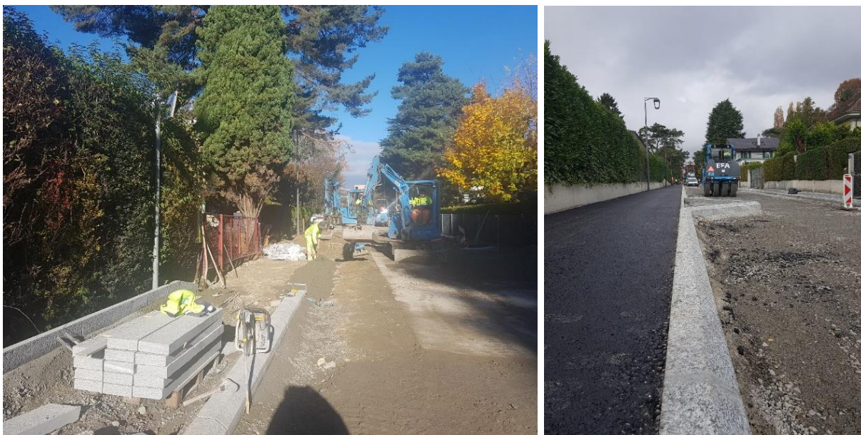
Réaménagement de la chaussée au chemin du Russel
