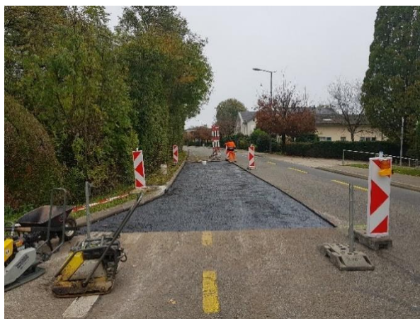
Réfections ponctuelles, Rue du Centre
