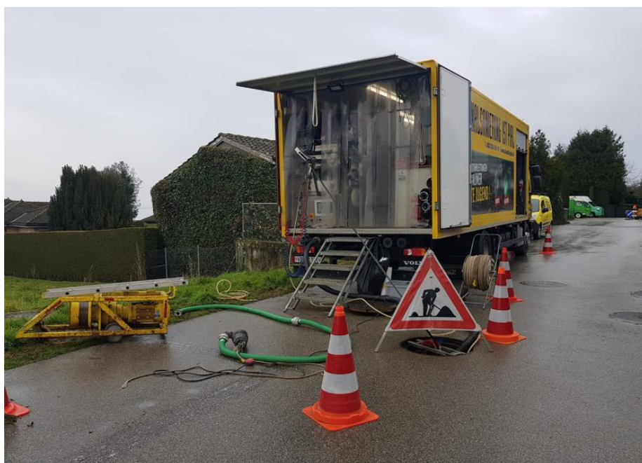
Installation pour la réhabilitation du collecteur de concentration
